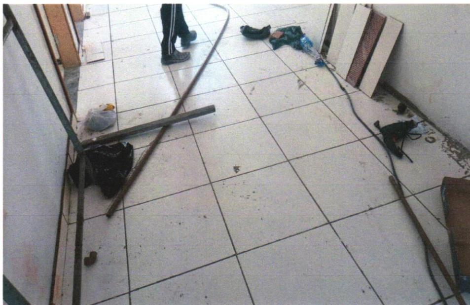
FOTO 27 - REVESTIMENTO CERÂMICO PARA PISO COM PLACAS TIPO ESMALTADA EXTRA DE DIMENSÕES 45X45 CM APLICADA EM AMBIENTES DE ÁREA ENTRE 5 M2 E 10 M2. AF\_06/2014
