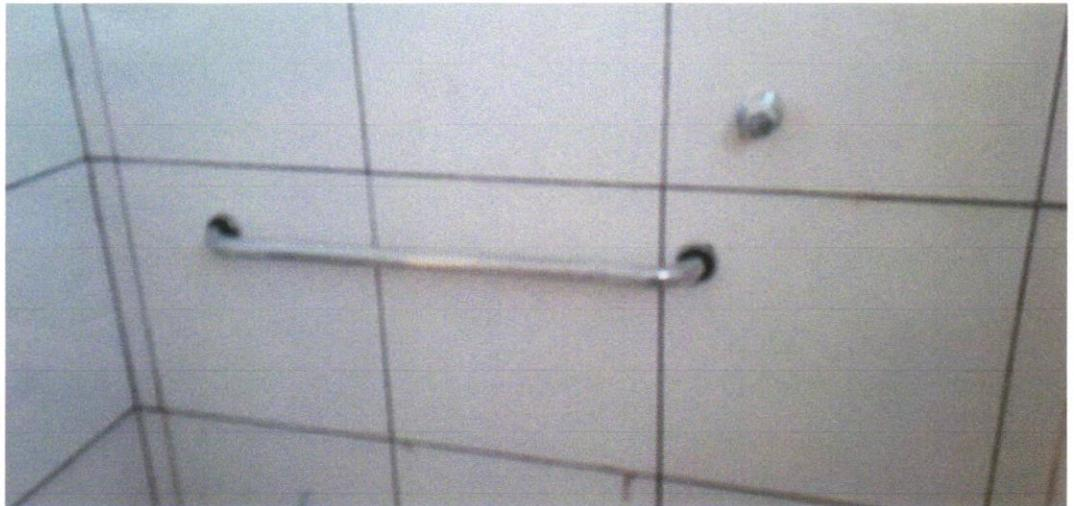
FOTO 37 - BARRA DE APOIO RETA, EM ALUMINIO, COMPRIMENTO 60 CM ,FIXADA NA PAREDE - FORNECIMENTO E INSTALAÇÃO. AF\_01/2020.
