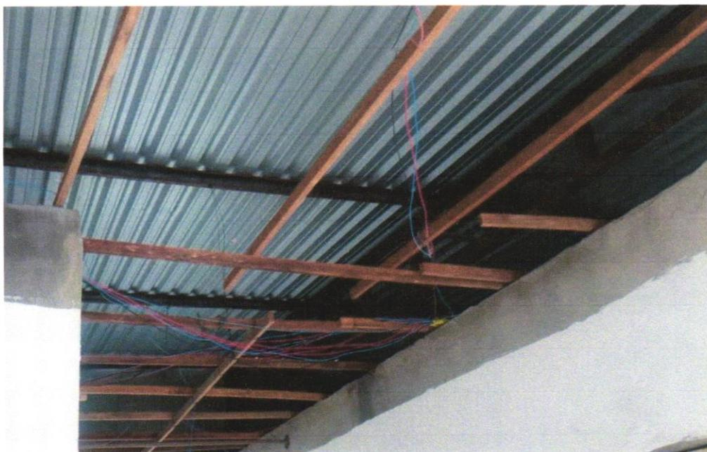
FOTO 13 - CABO DE COBRE FLEXÍVEL ISOLADO, 4 MM<sup>2</sup>, ANTI-CHAMA 450/750 V, PARA CIRCUITOS TERMINAIS - FORNECIMENTO E INSTALAÇÃO. AF\_12/2015
