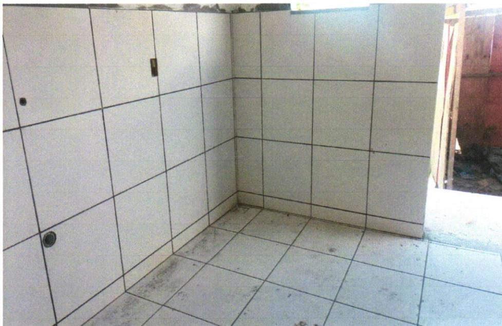
FOTO 29 - REVESTIMENTO CERÂMICO PARA PAREDES INTERNAS COM PLACAS TIPO ESMALTADA EXTRA DE DIMENSÕES 33X45 CM APLICADAS EM AMBIENTES DE ÁREA MAIOR QUE 5 M<sup>2</sup> A MEIA ALTURA DAS PAREDES. AF\_06/2014
