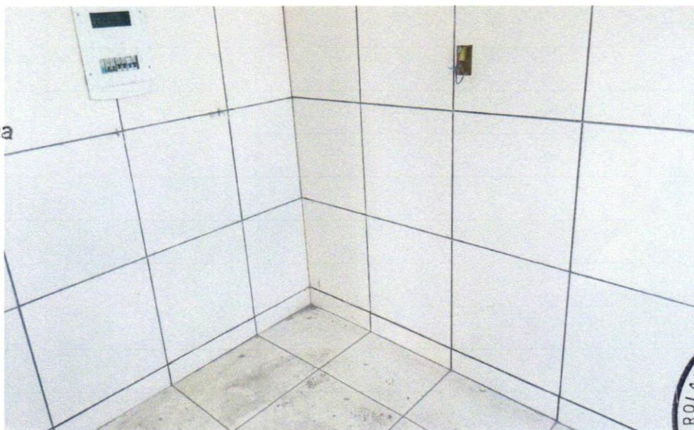
FOTO 28 - REVESTIMENTO CERÂMICO PARA PAREDES INTERNAS COM PLACAS TIPO ESMALTADA EXTRA DE DIMENSÕES 33X45 CM APLICADAS EM AMBIENTES DE ÁREA MAIOR QUE 5 M² A MEIA ALTURA DAS PAREDES. AF\_06/2014
